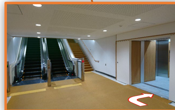
本館・分館連絡地下道の 段差解消のためエレベーター新設
