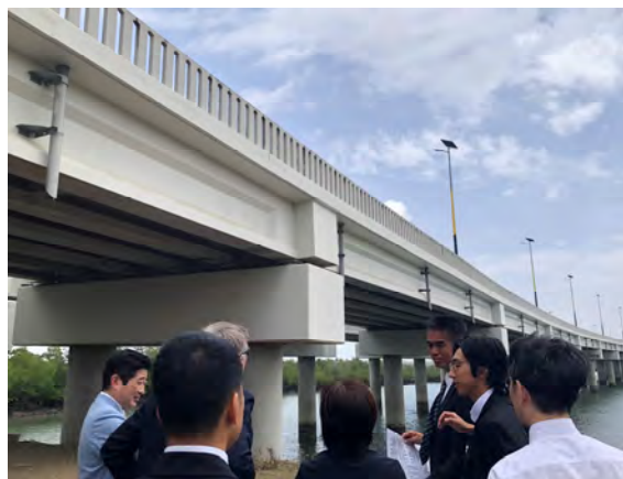
（写真）モンバサ港から南部地域へのバイパス道路
