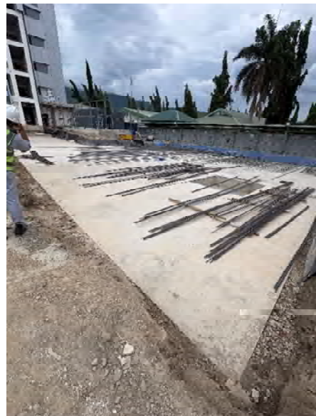
(写真) 病棟建設現場
