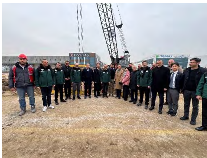
（写真）アンカラ給水計画導水管更新サイトにて
