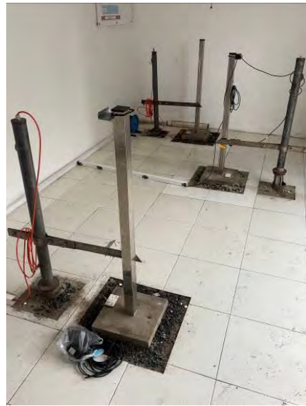
(写真) 地盤沈下観測井戸
