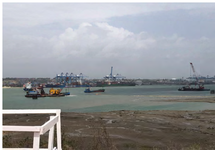
（写真） 棧橋の建設工事現場
