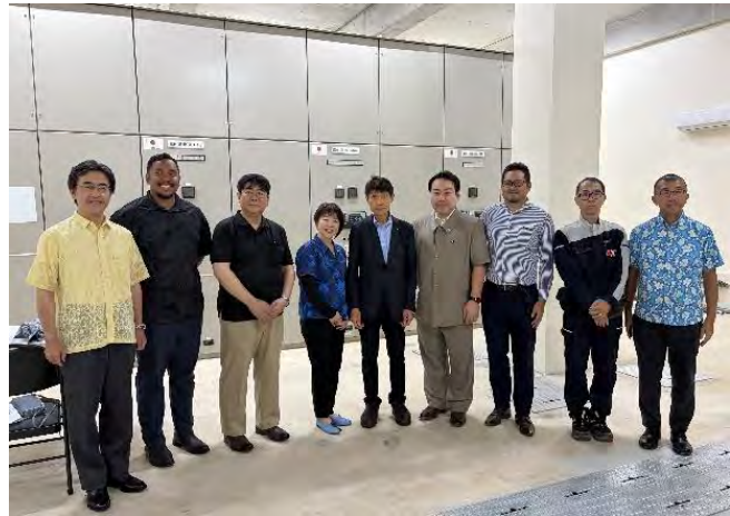
（写真）コクサイ変電所にて
