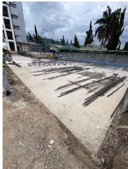
(写真) 病棟建設現場
