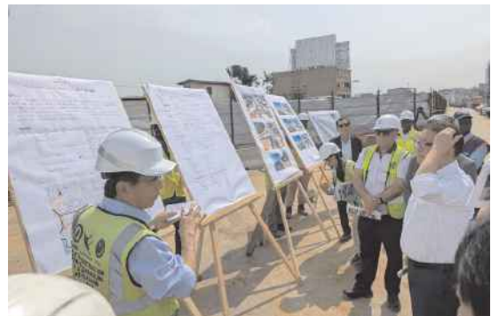
（写真）建設現場での説明聴取の様子
