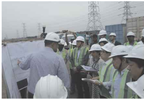
（写真）周辺環状道路の建設現場の視察
