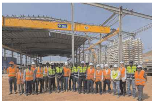
(写真) 建設中の海水淡水化施設敷地内にて
