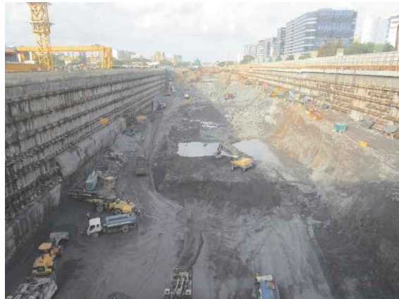
(写真) BKC駅の建設現場
