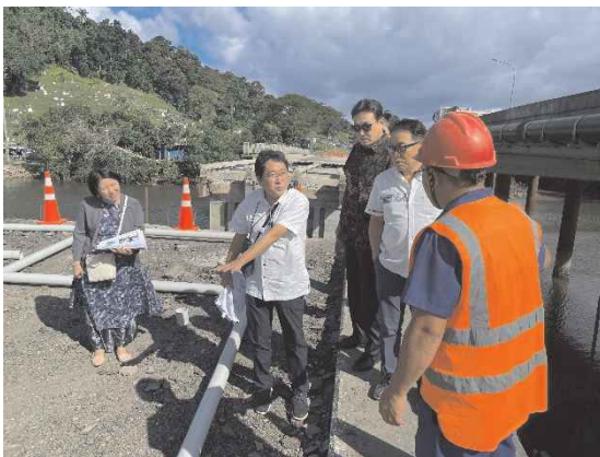
（写真）解体工事現場の視察
