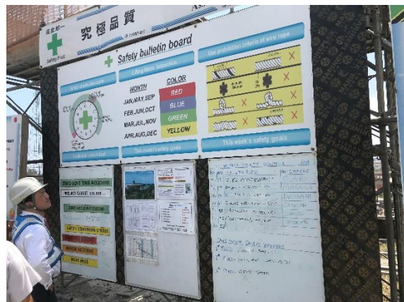
（写真）ゲレザニ交差点整備現場の安全パネル
