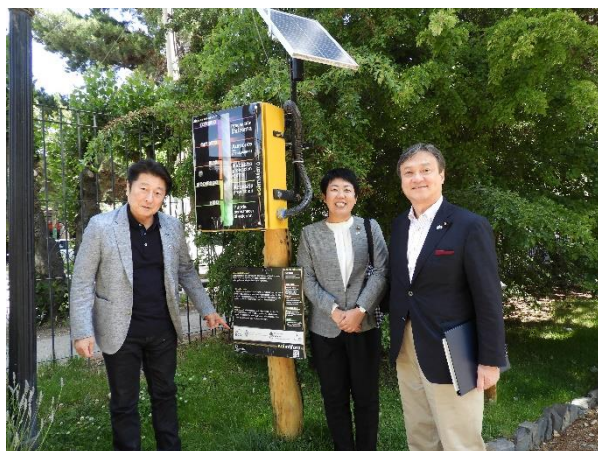
(写真) 事務所敷地に設置された紫外線信号機
