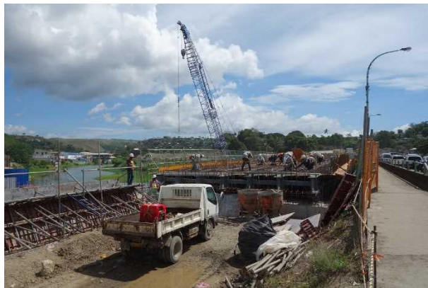
（写真）新マタニコ橋の拡張工事
