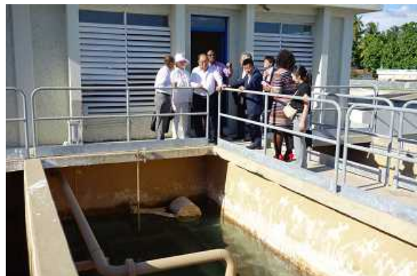
（写真）スパニッシュタウン浄水場の沈殿池
