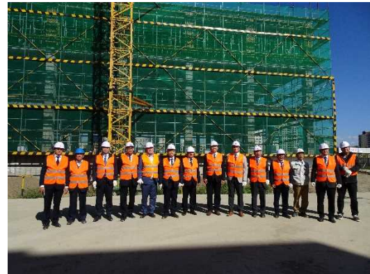
（写真）日本モンゴル教育病院建設現場にて
