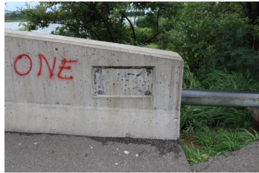
銘板が消失した橋梁部分
