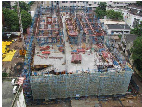
（写真）建設中の新総合外来棟
