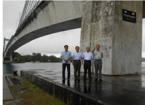
（写真）日本・パラオ友好橋
