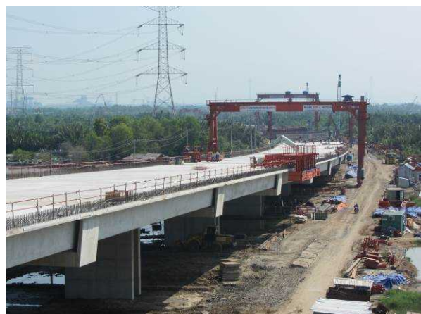
（写真）建設中の南北高速道路の現状
