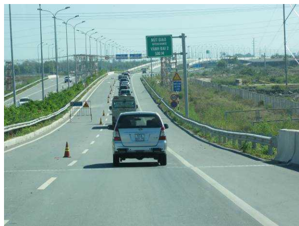
（写真）南北高速道路の状況
