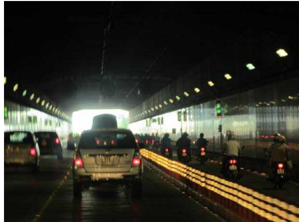
（写真）サイゴン川を渡河するトンネル内
