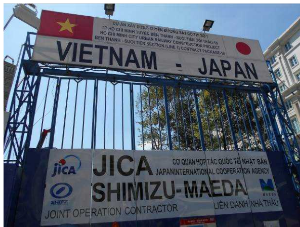
(写真) 日本の支援により建設中であることを示す掲示
