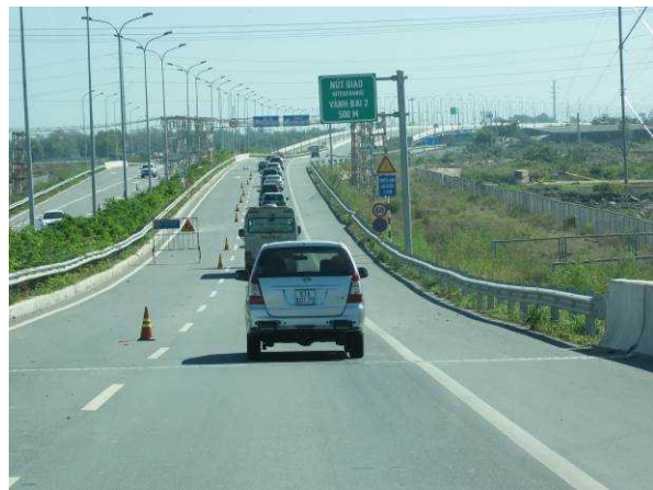
(写真) 南北高速道路の状況
