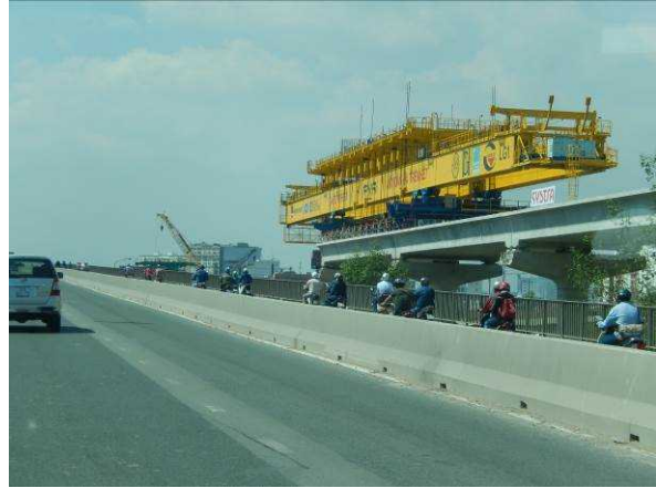
(写真) 建設中のホーチミン市都市鉄道（1号線）
