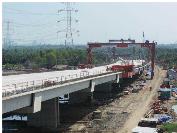
（写真）建設中の南北高速道路の現状
