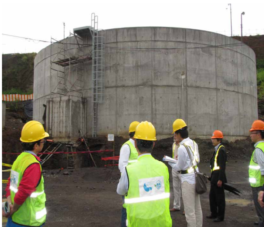
（写真）建設中の下水処理施設
