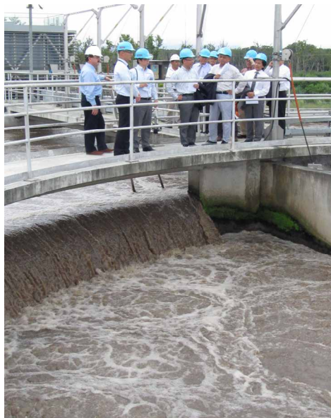
(写真) 下水処理施設の状況
