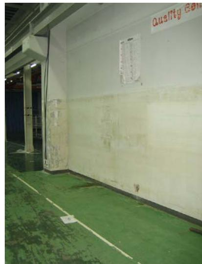
(写真) 工場の壁に残る冠水の跡
