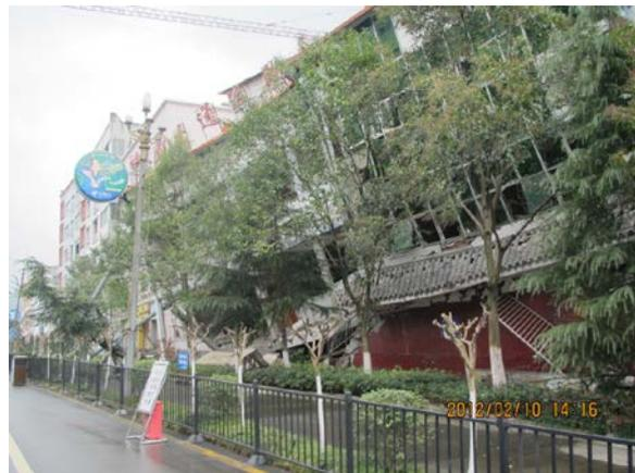
(写真) 保存されている倒壊した建物
