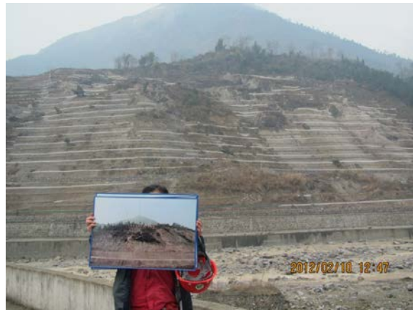
（写真）崩壊状況（パネル）と復旧した山腹
