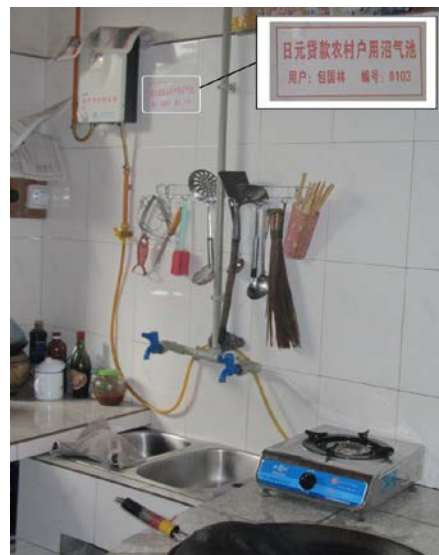
（写真）農家用メタンガス施設
