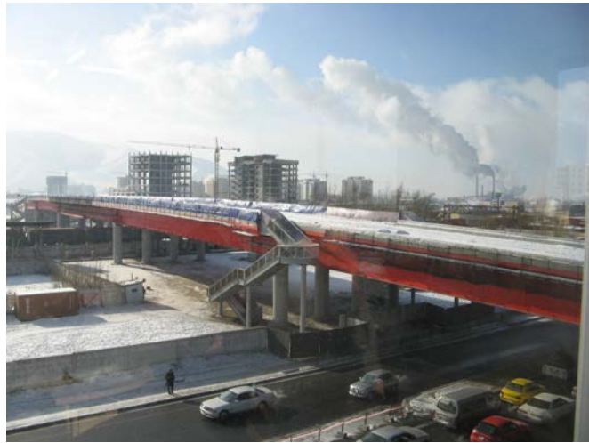
（写真）建設中の跨線橋（太陽橋）
