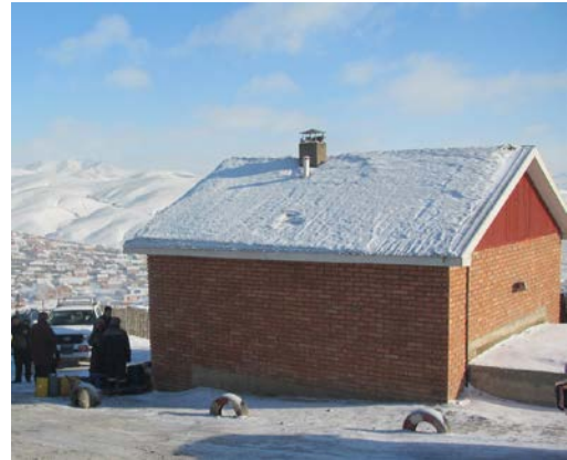
(写真) ゲル地区の簡易給水設備
