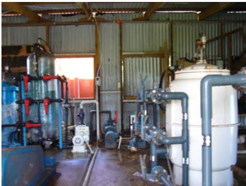
（写真）給水施設内の状況
