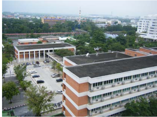
(写真) 屋上より大学構内を俯瞰
