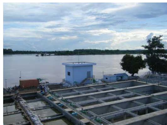
(写真) 拡張工事が行われているカオリオ浄水場
