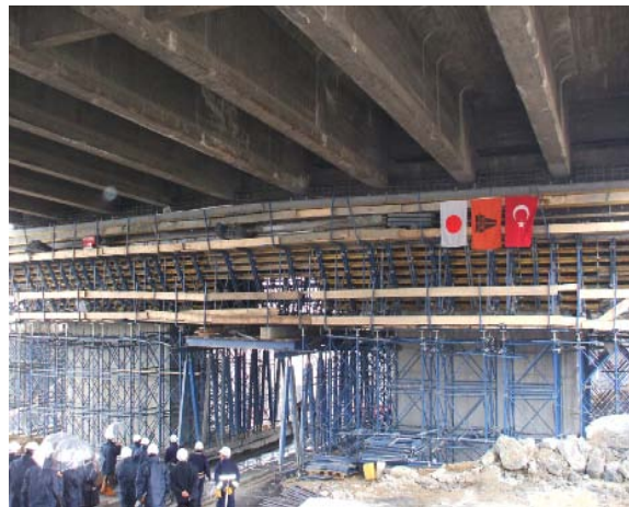
(写真) 橋脚の耐震補強工事現場
