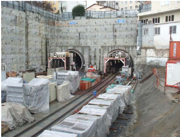
（写真）トンネル工事現場
