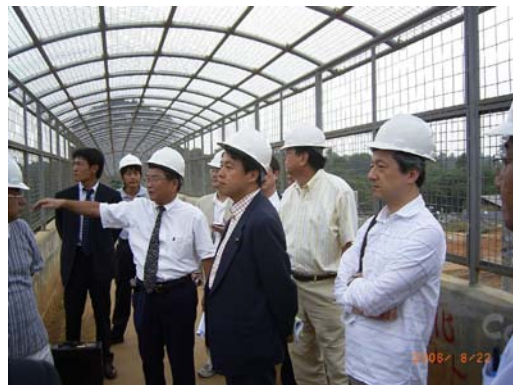
(写真) 工事現場での説明
