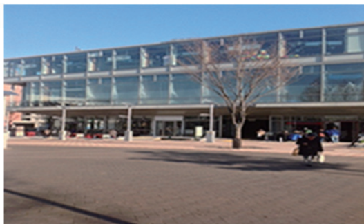
写真3 横浜市内の木造商業施設
