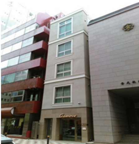
写真1 東京都内に登場した木造ビル
