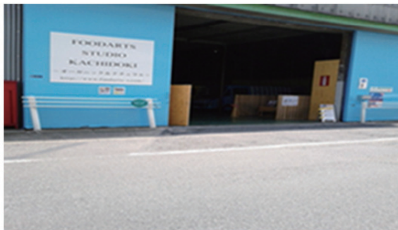
写真5 CLT材を用いた部屋のある倉庫
