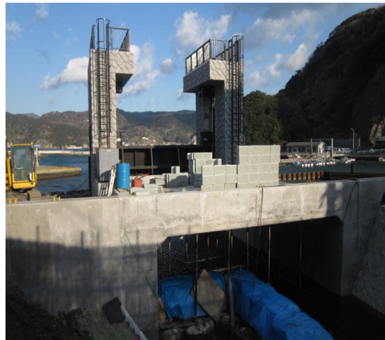
漁港における水門建設工事 44 (平成24年12月、静岡県にて筆者撮影)
