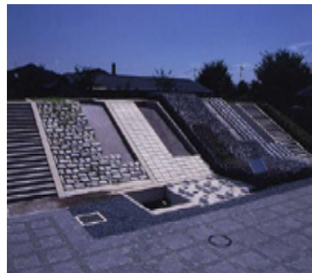
安中研修所の河川護岸モデル （写真提供：会計検査院）
