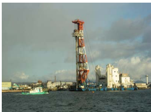
耐震強化岸壁施工予定箇所の地盤改良工事 38 (平成24年12月、北海道にて筆者撮影)
