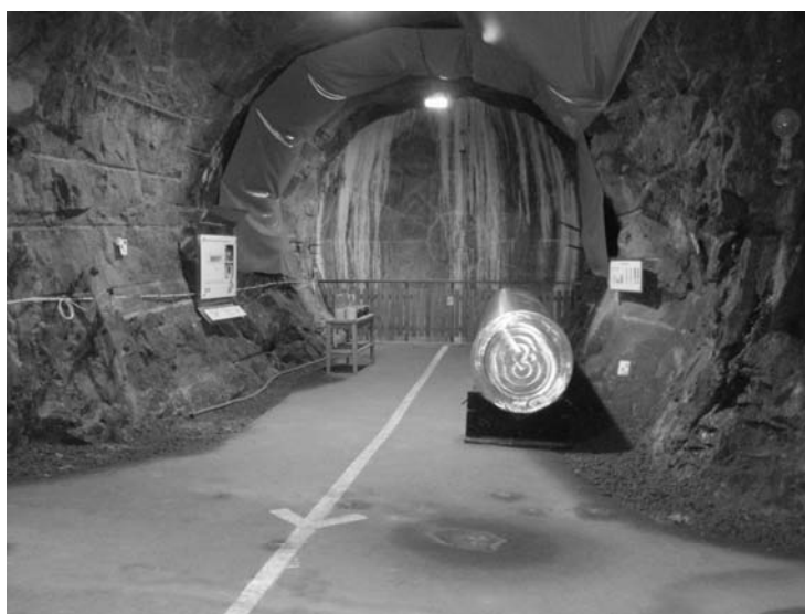
(写真) エスポ岩盤研究所 キャニスタと埋設場所の模擬展示
