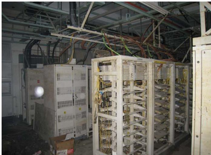
津波により被害を受けた通信設備（NTT女川ビル）
