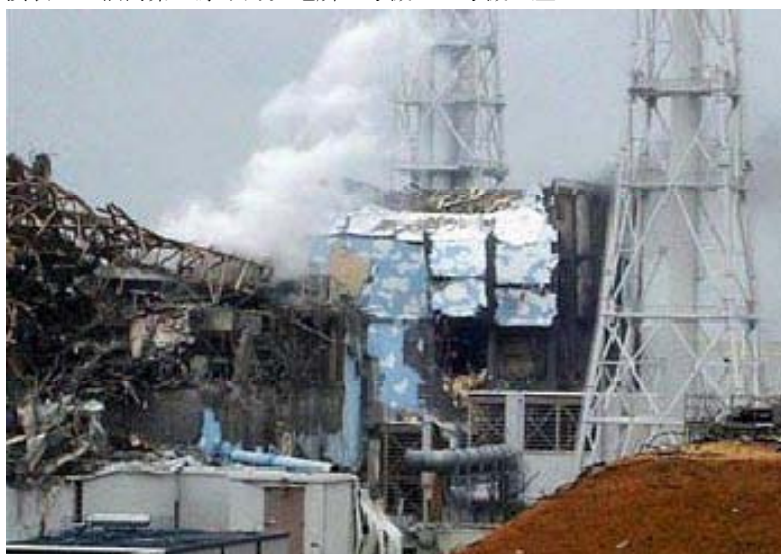
損壊した福島第一原子力発電所 3 号機・4 号機建屋
