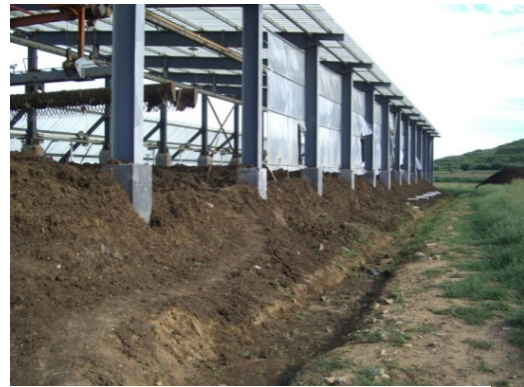
牛糞堆肥化施設
