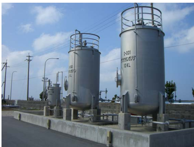
エタノールタンク（左）とガソリンタンク（右、真ん中） E 3 供給スタンド （いずれも（株）りゅうせき敷地内：筆者撮影）
