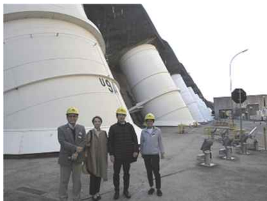
（写真）イタイプ水力発電所の視察
