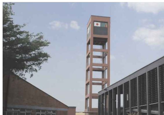
(写真) カニヤマ病院の高架水槽
