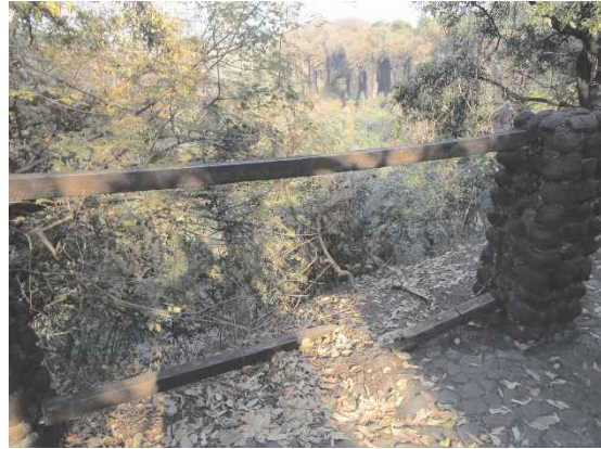
(写真) 遊歩道の柵
