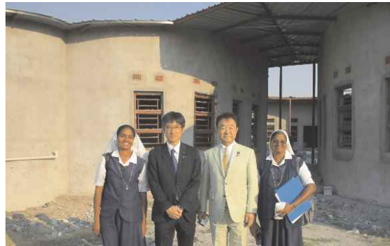
(写真) 建設中の職業訓練校の外観
