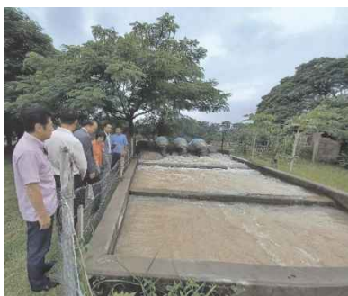
(写真) 奥に見えるのが改修されたポンプ3基
