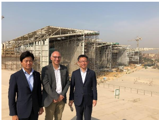
(写真) 大エジプト博物館建設現場
