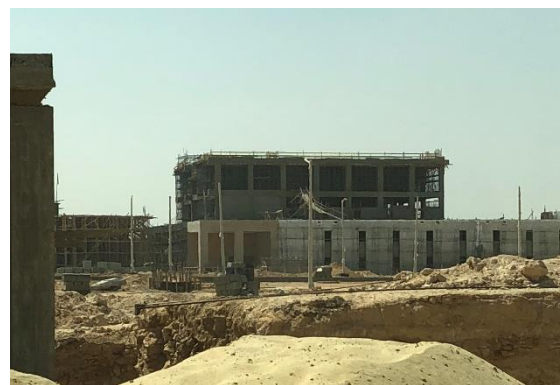
(写真) キャンパス拡張工事現場
