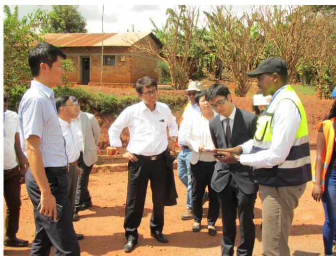
（写真）道路整備の現場で説明を受ける
