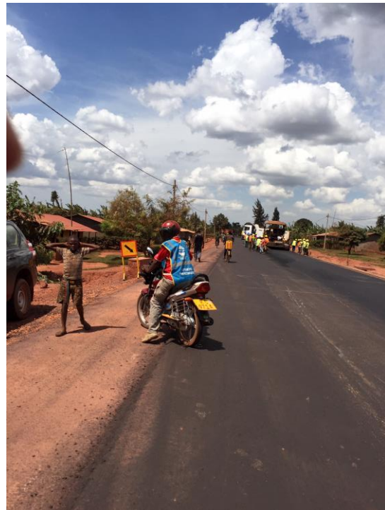
（写真）改良事業後のルスモ-カヨンザ区間道路
