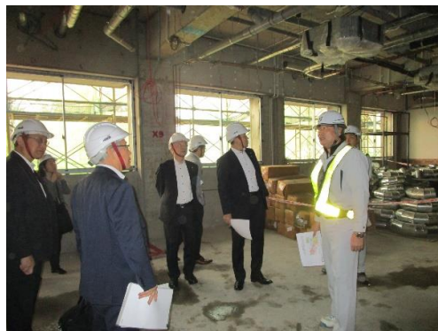
（写真）建築現場
