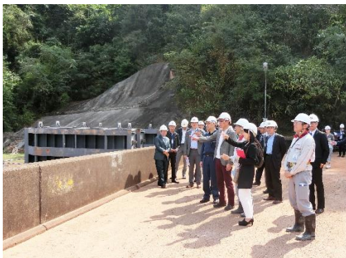
（写真）ナムグムダム工事現場
