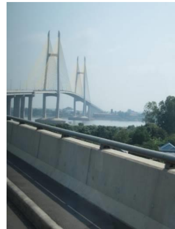
（写真）取付道路から見た つばさ橋
