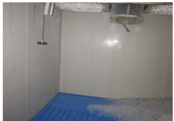
（写真）製氷施設内部
