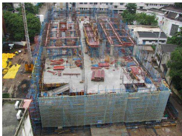
(写真) 建設中の新総合外来棟
