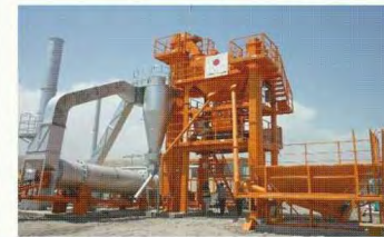
← 無償資金協力案件で設置されたアスファルトプラント
