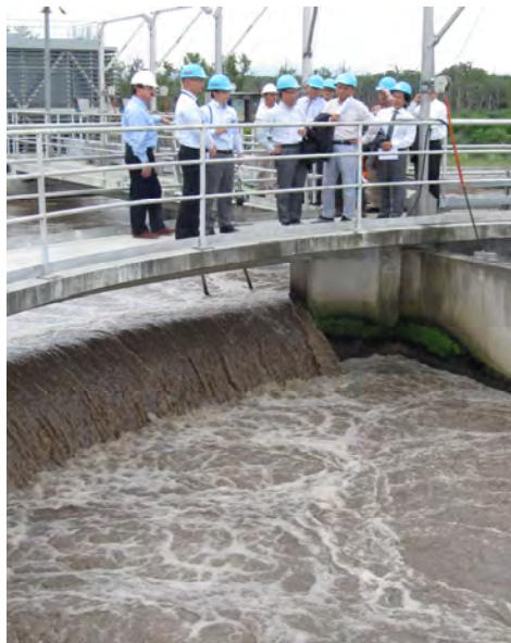
(写真) 下水処理施設の状況
