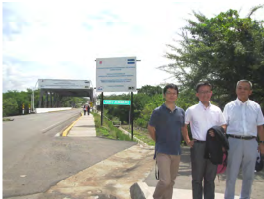
(写真) ラス・バンデラス橋の現状
