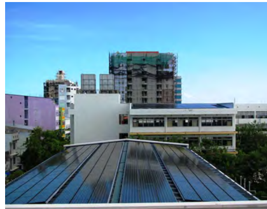
（写真）学校の屋根に太陽光パネルを設置
