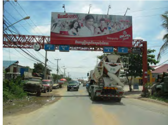
(写真) 国道1号線改修計画による整備箇所
