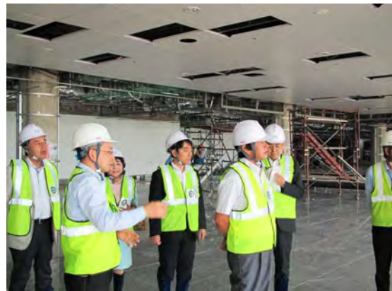
（写真）出発階の工事現場
