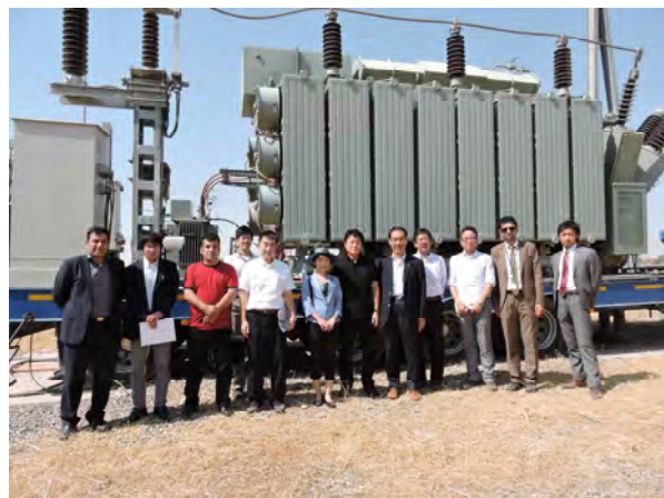
（写真）移動式変電所の前で
