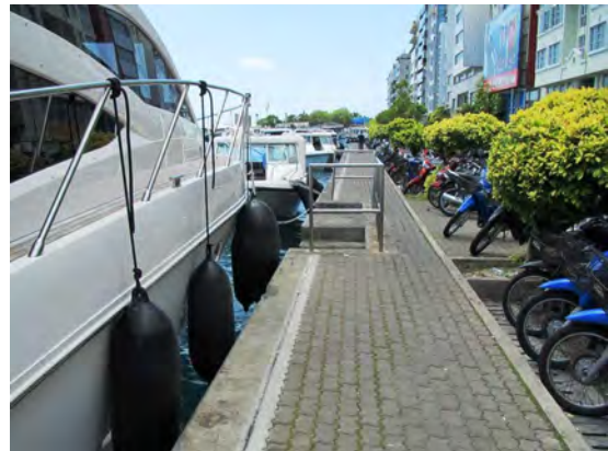
（写真）北岸側の港湾の船着き場の修復箇所
