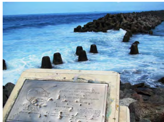
(写真) 離岸堤の開口部及びODA銘板
