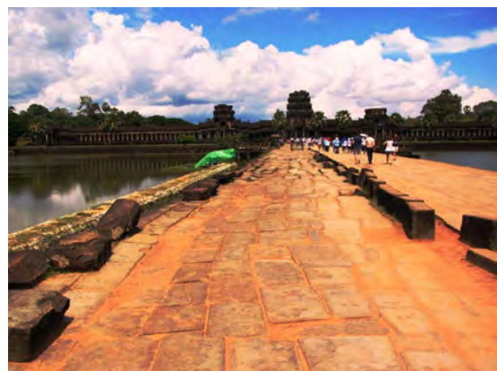
(写真) 西参道の修復箇所の状況
