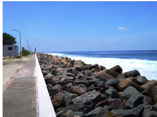
(写真) マレ島南岸の護岸堤
