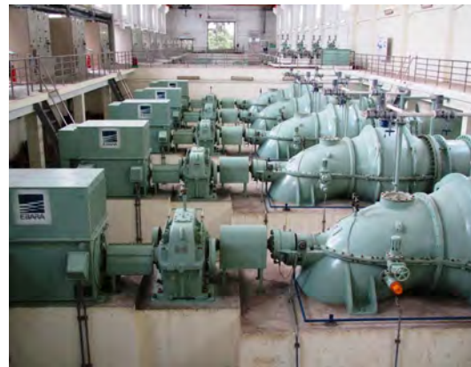
(写真) イエンソー排水ポンプ施設
