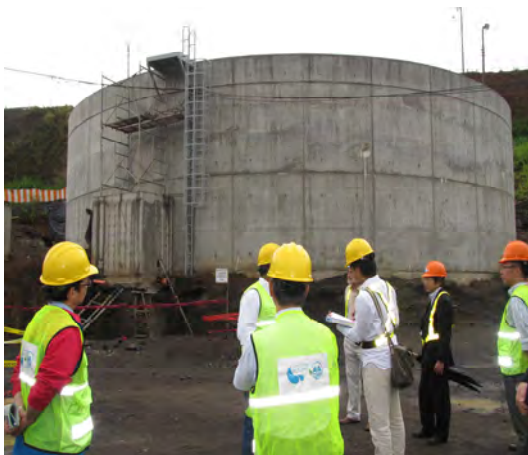
（写真）建設中の下水処理施設
