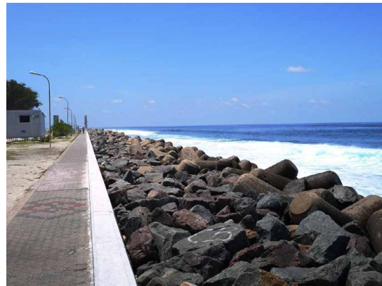
(写真) マレ島南岸の護岸堤
