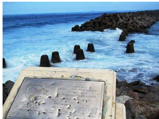
(写真) 離岸堤の開口部及びODA銘板
