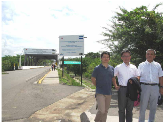
（写真）ラス・バンデラス橋の現状
