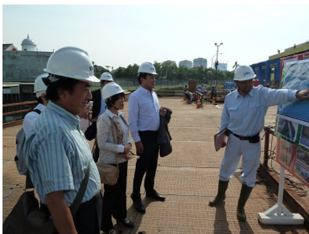
（写真）プルイット排水機場工事現場を視察
