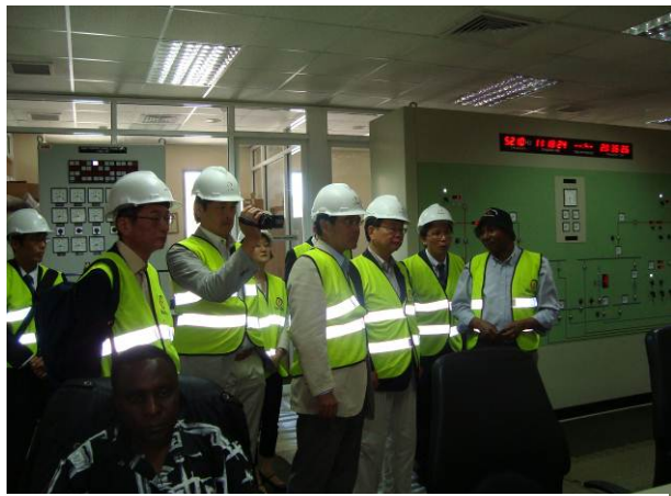
(写真) オルカリア地熱発電所視察の様子
