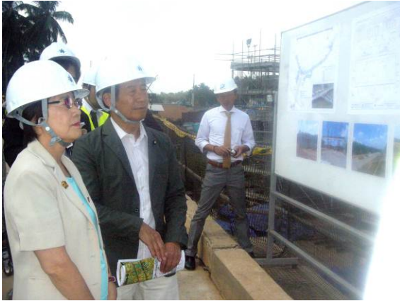
(写真) 工事の進捗状況の説明聴取
