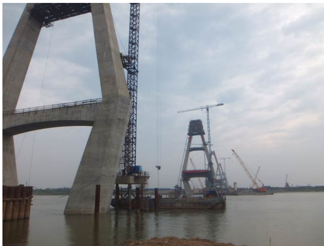
（写真）建設中の橋脚
