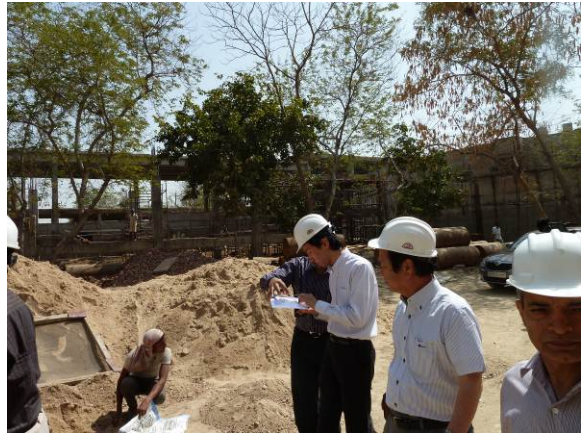
（写真）導水管等の建設工事
