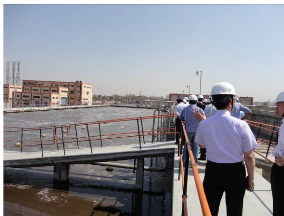
(写真) オクラ下水処理場内の汚水処理施設
