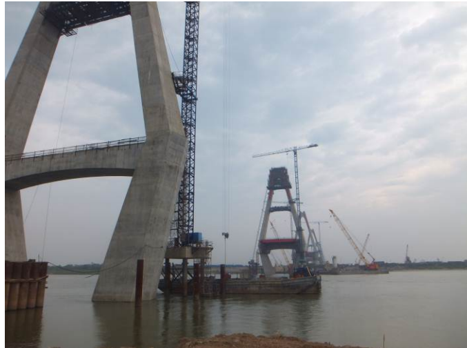
（写真）建設中の橋脚
