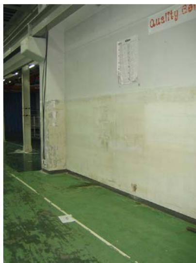
(写真) 工場の壁に残る冠水の跡
