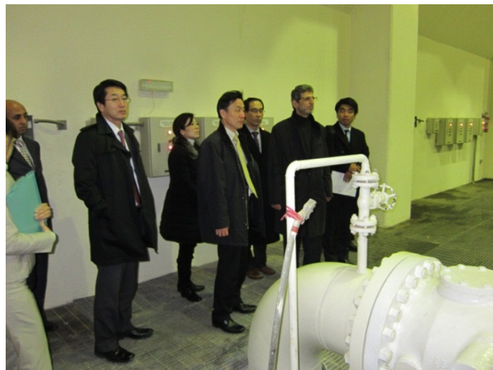
(写真) 原水揚水用第3ポンプ場
