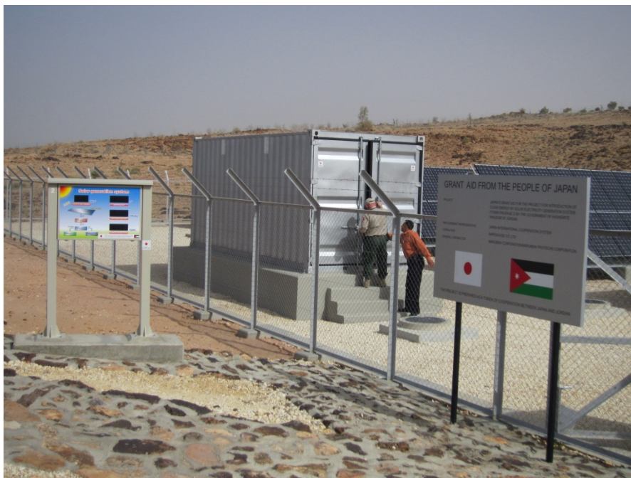
(写真) 太陽光発電施設
