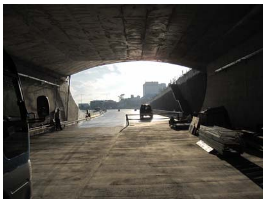
(写真) サイゴン東西ハイウェイ建設現場にて
