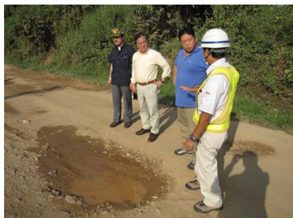
（写真）建設会社より道路状況について聴取
