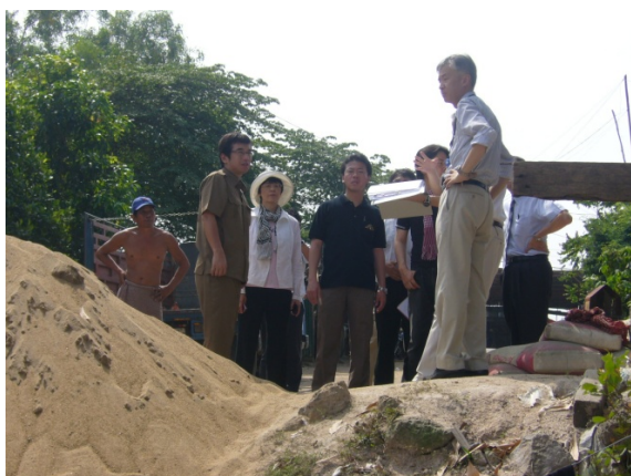
(写真) ネアックルン橋梁建設予定地の視察
