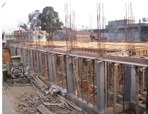
（写真）建設中の新施設
