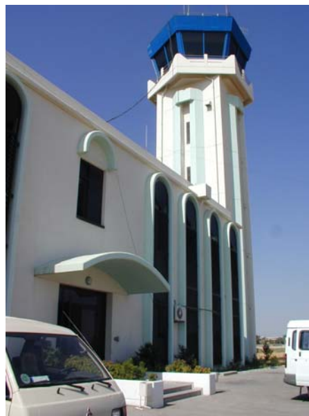
(写真) 整備された管制塔
