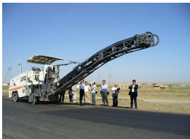
(写真) 供与された道路建設機材を視察
